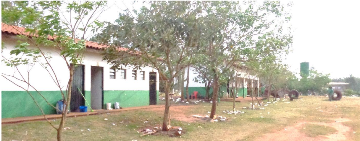
Figura 31 – Estrutura para funcionamento do escritório, banheiro, cozinha e almoxarifado existente na área de operação da UTR, UC e Aterro Sanitário do município de Naviraí/MS.
