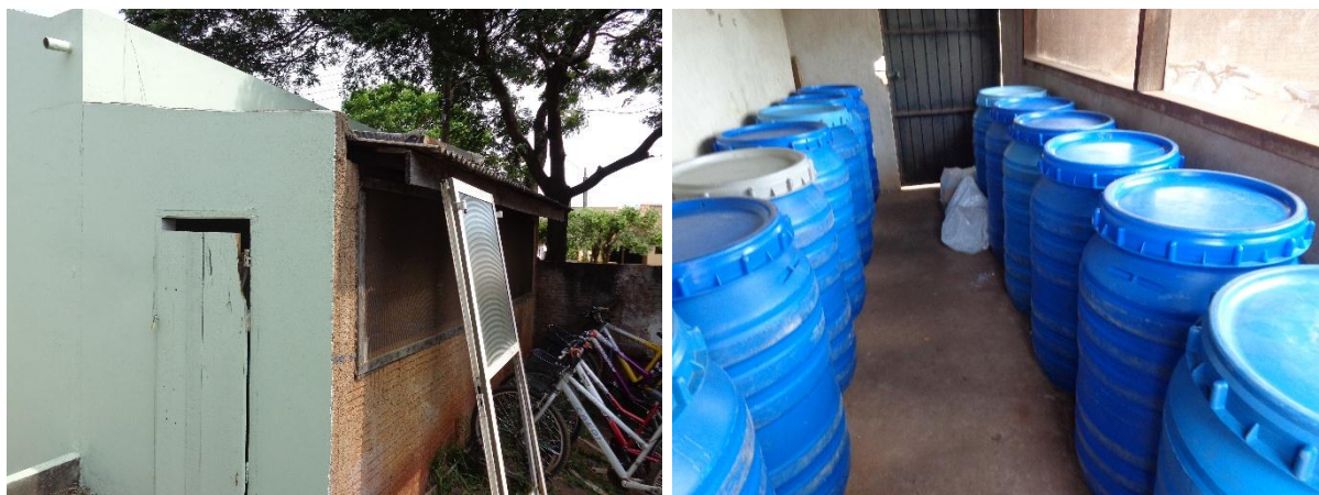
Figura 77 – Local de acondicionamento de RSS no Hospital Municipal de Naviraí.
