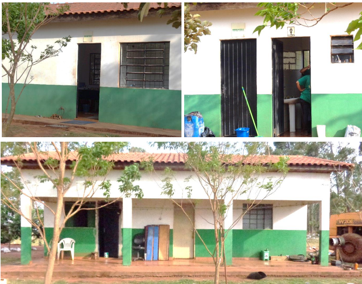
Figura 38 – Estruturas para escritório, banheiros, refeitório e almoxarifado existente no aterro sanitário municipal de Naviraí/MS.
