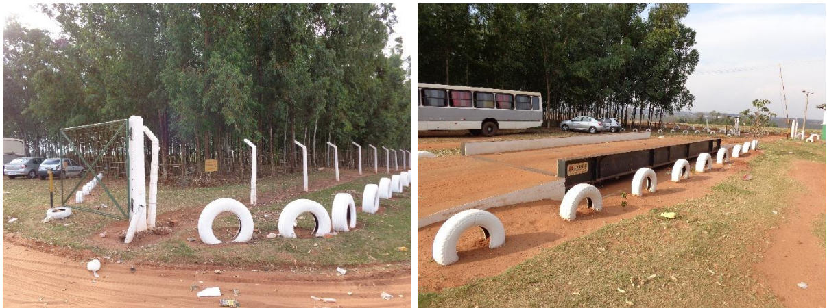
Figura 37 – Entrada do aterro sanitário evidenciando o portão de entrada, cercamento, sinalização e cortina arbórea.
