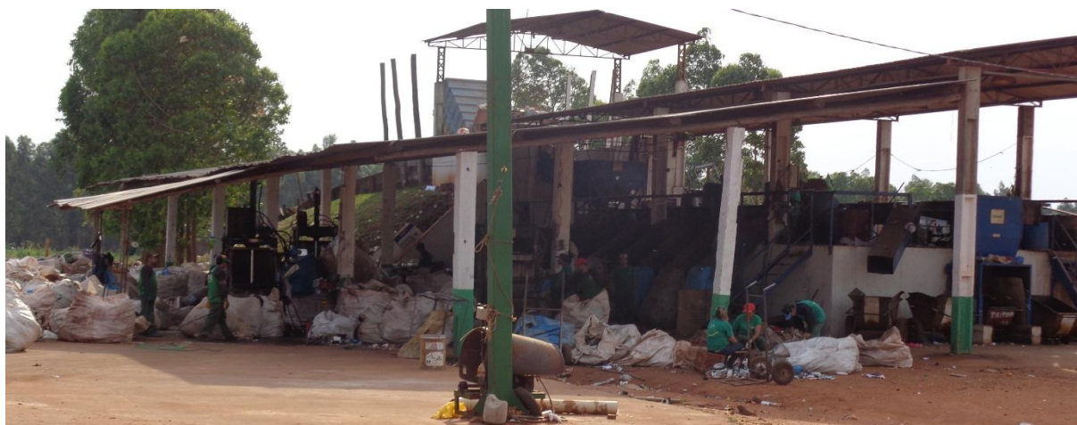
Figura 23 – Unidade de Triagem de Resíduos no município de Naviraí/MS
