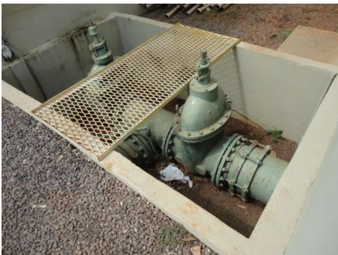
FIGURA 30: CONEXÃO DOS RESERVATÓRIOS.
