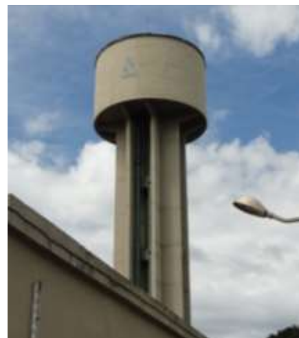
FIGURA 29: RESERVATÓRIO ELEVADO DE 200 M 3 .
