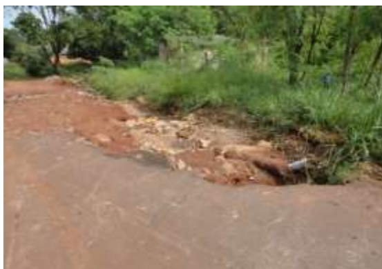
FIGURA 62: FIM DA PAVIMENTAÇÃO E INÍCIO DE PROCESSO EROSIVO.
