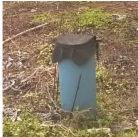
FIGURA 87: POÇO SEMI-ARTESIANO DESATIVADO DO DISTRITO DE PORTO CAIUÁ
