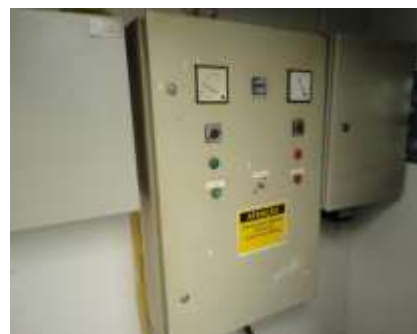
FIGURA 13: PAINEL ELÉTRICO E SISTEMA DE TELECOMANDO.
