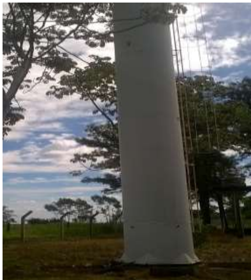
FIGURA 86: RESERVATÓRIO DESATIVADO DO DISTRITO DE PORTO CAIUÁ
