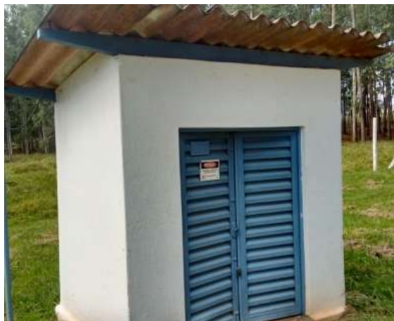
FIGURA 25: LOCAL DE INSTALAÇÃO DO PAINEL ELÉTRICO E SISTEMA DE TELECOMANDO.
