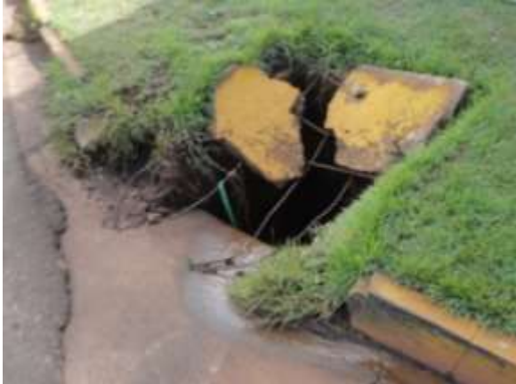
FIGURA 59: CAIXA COLETORA SEM TAMPA.
