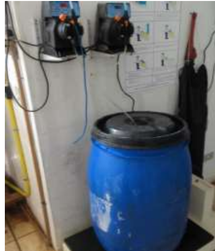
FIGURA 33: DOSADOR DE ORTO-POLIFOSFATO.
