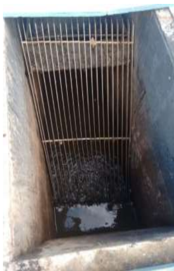
FIGURA 46: GRADEAMENTO.
