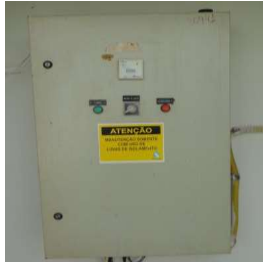
FIGURA 19: PAINEL ELÉTRICO E SISTEMA DE TELECOMANDO.
