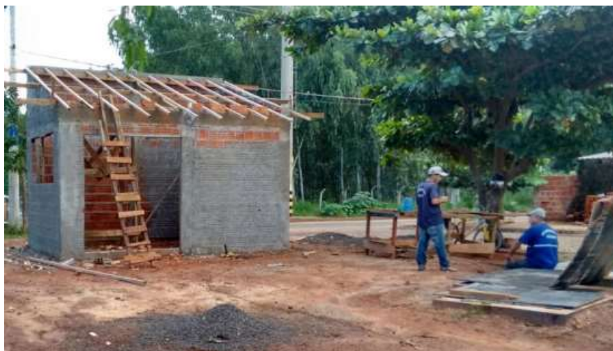
FIGURA 52: ELEVATÓRIA DE ESGOTO EM IMPLANTAÇÃO.
