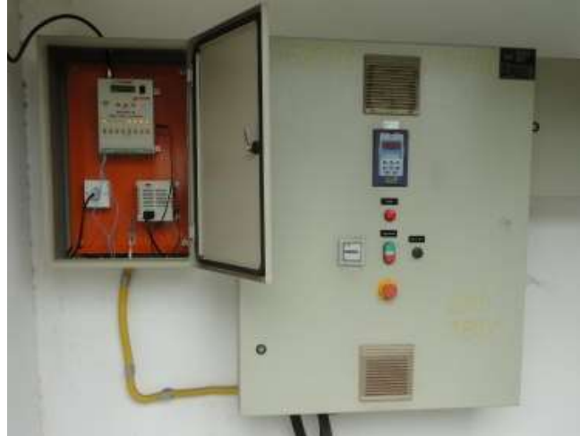
FIGURA 9: PAINEL ELÉTRICO E SISTEMA DE TELECOMANDO.
