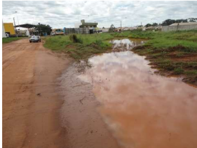
FIGURA 68: PONTO CRÍTICO COM ACÚMULO DA ÁGUA DA CHUVA.
