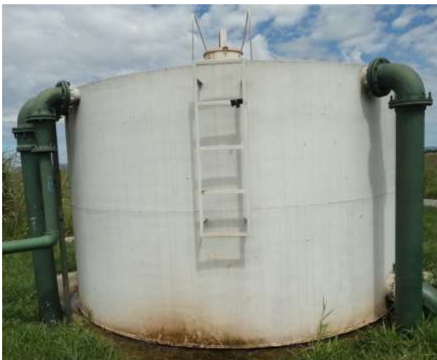
FIGURA 20: CAIXA DE REUNIÃO DOS POÇOS N° 005, 012, 013 E 017.
