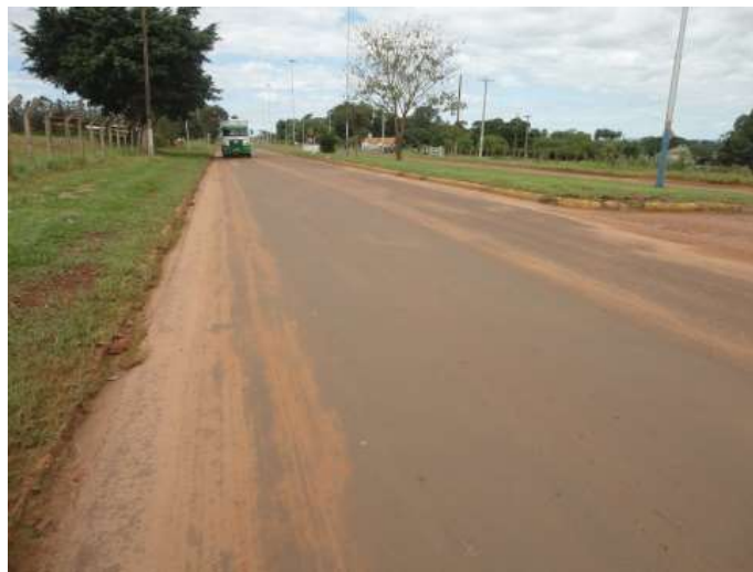
FIGURA 69: PONTO DE ALAGAMENTO DURANTE CHUVAS INTENSAS.
