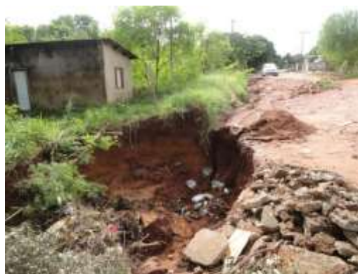
FIGURA 63: EROSÃO NA ÁREA URBANA.
