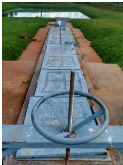
FIGURA 47: DESARENADOR E MEDIDOR DE VAZÃO (CALHA PARSHALL).
