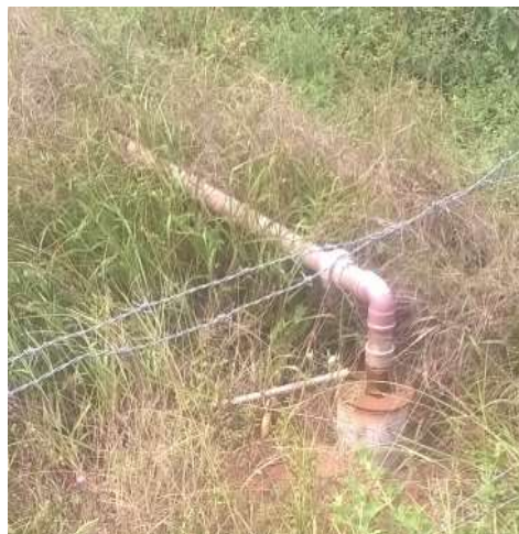
FIGURA 80: POÇO SEMI-ARTESIANO PARA ABASTECIMENTO DO DISTRITO VERDE.
