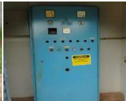
FIGURA 11: PAINEL ELÉTRICO E SISTEMA DE TELECOMANDO.
