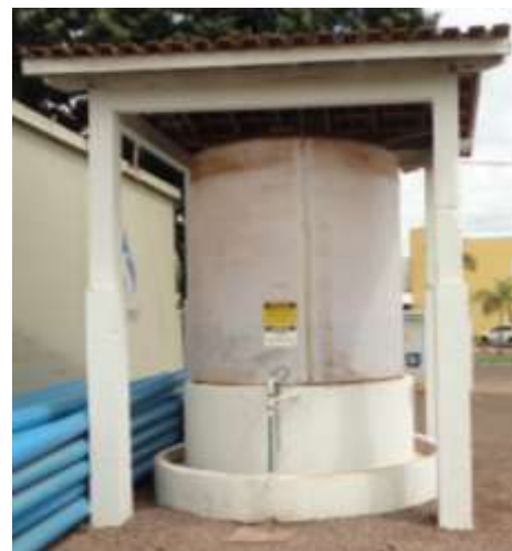
FIGURA 31: RESERVATÓRIO DE ÁCIDO FLUOSSILÍCICO.
