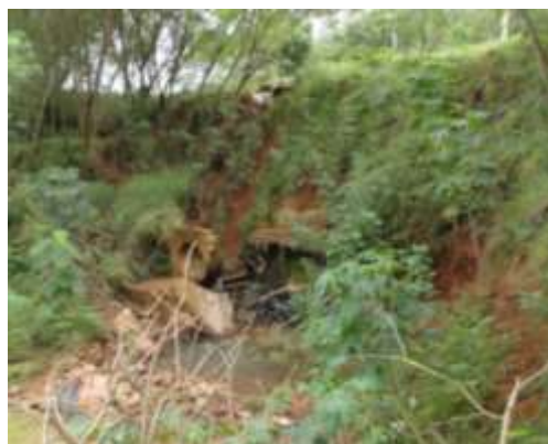
FIGURA 65: TUBULAÇÃO DE DRENAGEM DANIFICADA.
