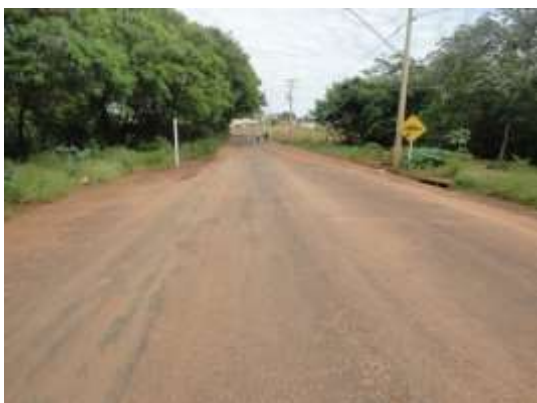
FIGURA 64: TRECHO EM QUE OCORRE ALAGAMENTO.
