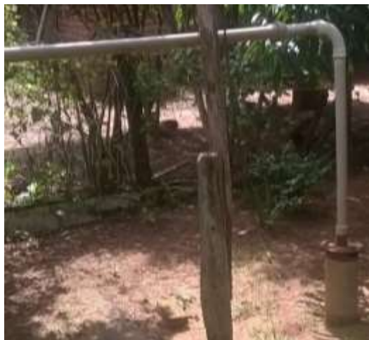
FIGURA 89: POÇO PARTICULAR QUE ABASTECE O DISTRITO DE PORTO CAIUÁ
