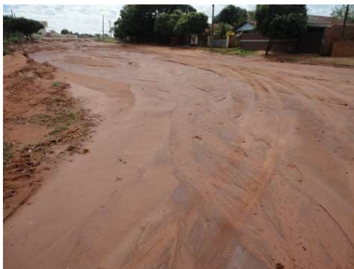
FIGURA 71: TRECHO NÃO PAVIMENTADO COM INÍCIO DE PROCESSO EROSIVO.
