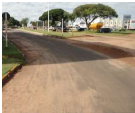
FIGURA 57: RUA COM ACÚMULO DE SOLO TRANSPORTADO PELA CHUVA.
