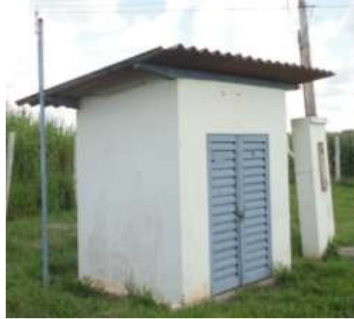
FIGURA 22: LOCAL DE INSTALAÇÃO DO PAINEL ELÉTRICO E SISTEMA DE TELECOMANDO.
