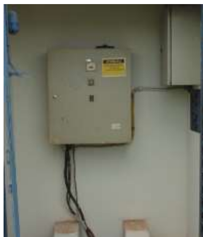
FIGURA 17: PAINEL ELÉTRICO E SISTEMA DE TELECOMANDO.
