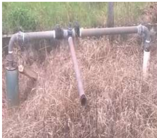
FIGURA 84: POÇO ARTESIANO DO ASSENTAMENTO JUNCAL
