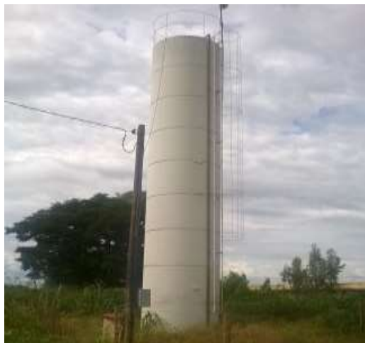
FIGURA 79: RESERVATÓRIO DO DISTRITO VERDE.
