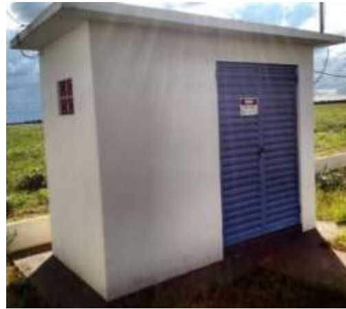
FIGURA 38: LOCAL DE INSTALAÇÃO DO PAINEL ELÉTRICO E DO SISTEMA DE TELECOMANDO.
