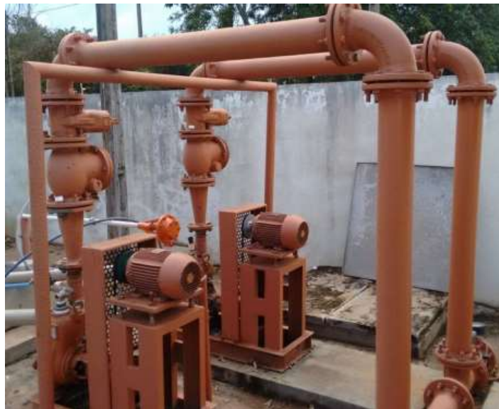
FIGURA 51: ELEVATÓRIA DE ESGOTO EM OPERAÇÃO.
