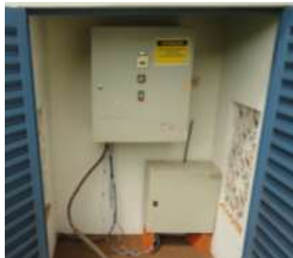
FIGURA 15: PAINEL ELÉTRICO E SISTEMA DE TELECOMANDO.
