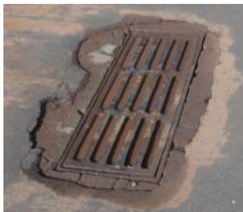
FIGURA 58: BOCA DE LOBO EVIDENCIANDO ENTUPIMENTO DA TUBULAÇÃO.
