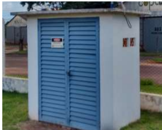
FIGURA 40: LOCAL DE INSTALAÇÃO DO PAINEL ELÉTRICO E DO SISTEMA DE TELECOMANDO.
