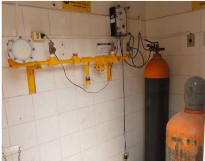
FIGURA 32: DOSADOR DE CLORO.
