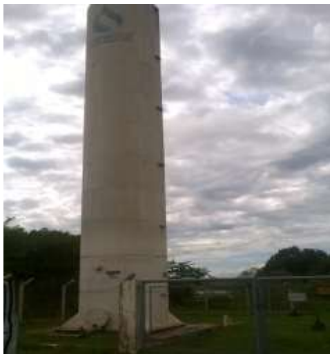
FIGURA 81: RESERVATÓRIO DA VILA INDUSTRIAL
