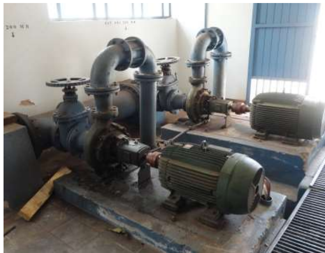
FIGURA 34: CONJUNTOS MOTOR-BOMBAS.
