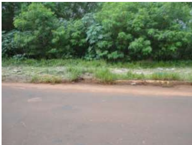
FIGURA 70: TRECHO CRÍTICO DE ALAGAMENTO COM ACÚMULO DE SEDIMENTOS.
