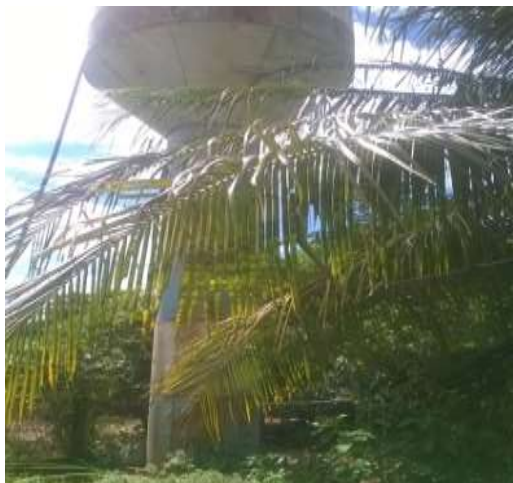
FIGURA 88: RESERVATÓRIO EM OPERAÇÃO NO DISTRITO DE PORTO CAIUÁ
