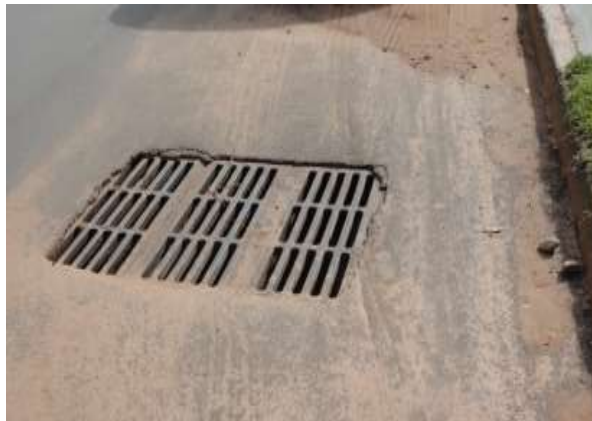
FIGURA 60: REGIÃO COM ACÚMULO DE SOLO TRANSPORTADO PELA CHUVA.
