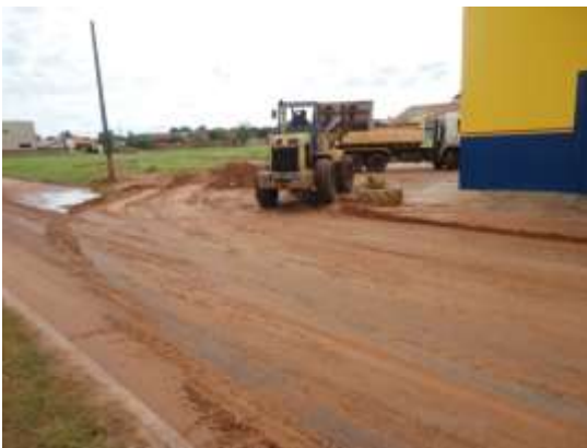
FIGURA 66: AVENIDA COBERTA DE SOLO CARREADO DURANTE A CHUVA.
