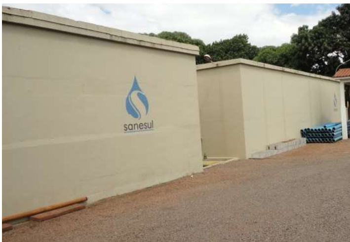
FIGURA 28: RESERVATÓRIOS APOIADOS (TOTAL DE 4.000 M 3 ).
