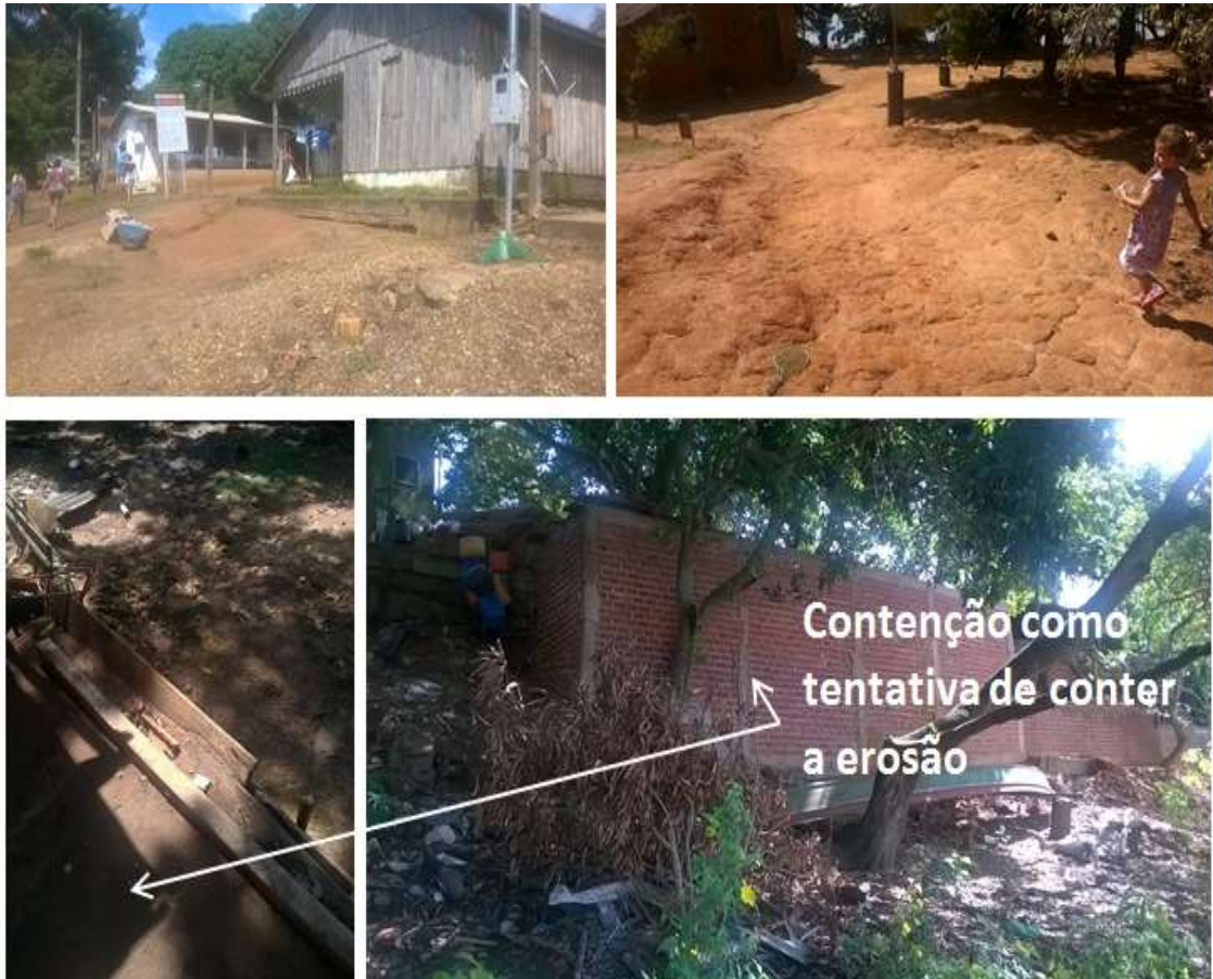
FIGURA 92: PONTOS DE EROSIÃO NO DISTRITO DE PORTO CAIUÁ E BARREIRAS DE CONTENÇÃO DE EROSIÃO.
