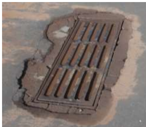
FIGURA 9: BOCA DE LOBO EVIDENCIANDO ENTUPIMENTO DA TUBULAÇÃO.
