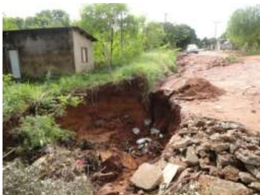
FIGURA 10: EROSION NA ÁREA URBANA.
