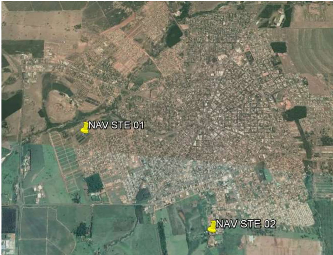
FIGURA 5: DISTRIBUIÇÃO ESPACIAL DOS PONTOS VISITADOS NO DIAGNÓSTICO DO SISTEMA DE ESGOTAMENTO SANITÁRIO DE NAVIRAÍ.
