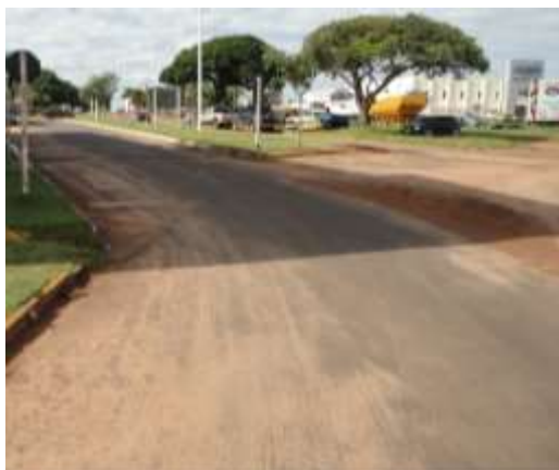
FIGURA 8: RUA COM ACÚMULO DE SOLO TRANSPORTADO PELA CHUVA.
