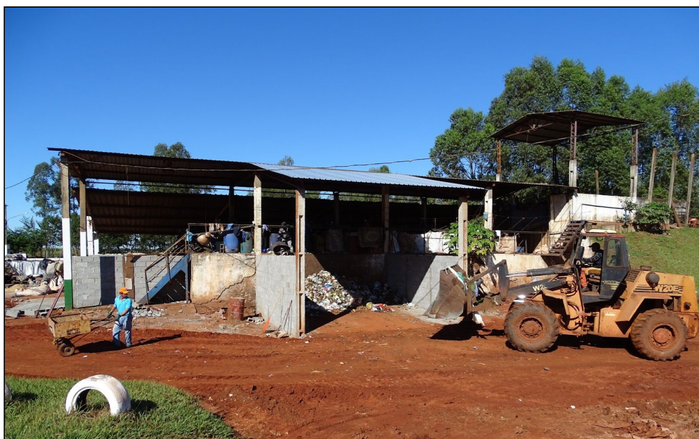
Figura 9 - Área externa da UTR
