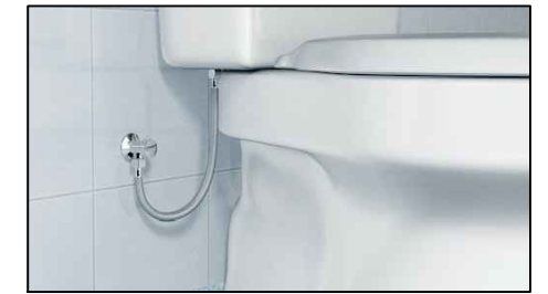
INSTALAR REGISTRO INDIVIDUAL PARA CAIXA ACOPLADA
