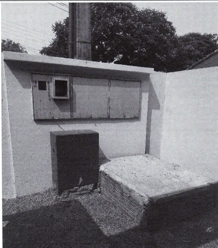
Figura 3 -mureta atual e caixa de passagem dos cabos
